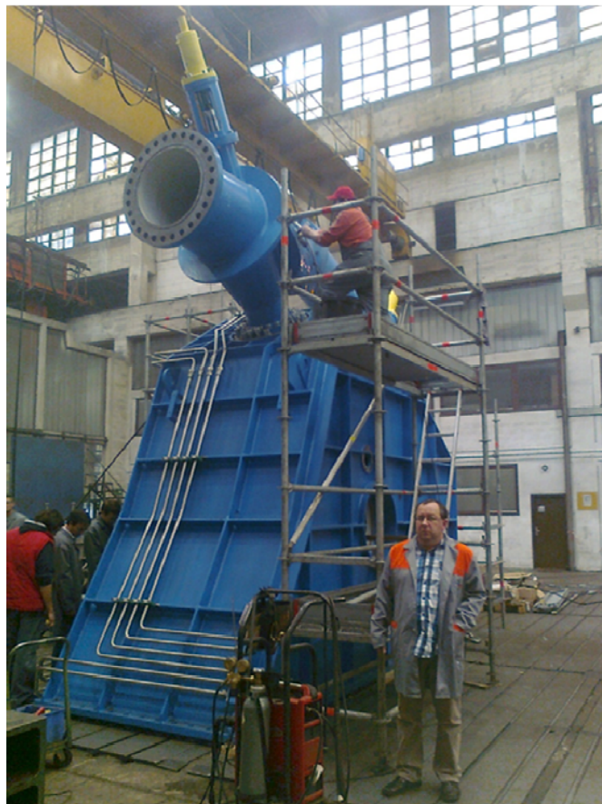
Montáž skříně s okružním potrubím Peltonovy turbíny
